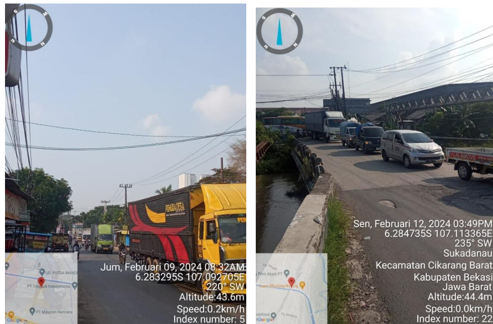
Gambar II.3 Truk Melintas Pada Jalan Yang Bukan Spesifikasinya (Jalan Bali Cikarang Barat dan Jalan Jarakosta Cikarang Barat)
