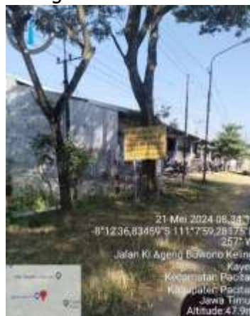
Gambar II.8 Kondisi Penerangan Jalan
