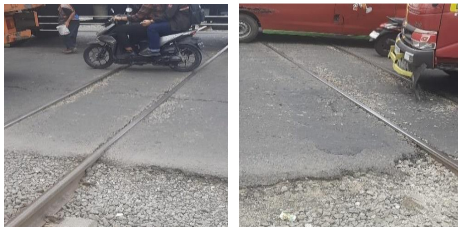
Gambar II. 7 Perkerasan di Perlintasan Sebidang JPL 118
