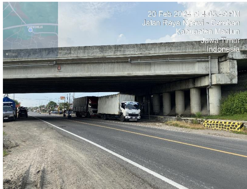
Gambar II. 6 Kendaraan Angkutan Barang yang Parkir di Ruas Jl. Raya Ngawi – Caruban Segmen 1
