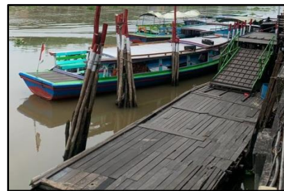
Gambar 6 Kondisi Eksisting Dermaga Kayu
