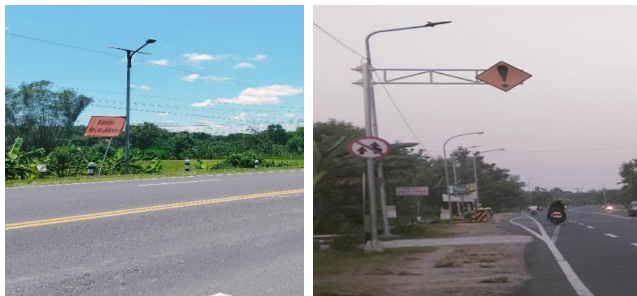
Gambar II. 5 Kondisi Rambu Berdasarkan Survei
