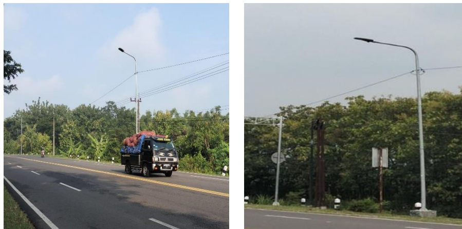
Gambar II. 7 Kondisi Penerangan Jalan Berdasarkan Survei
