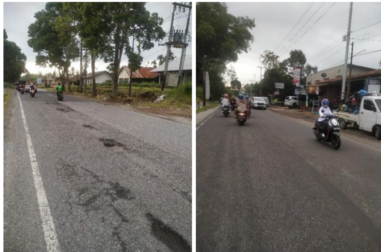
Gambar II. 7 Kondisi Fasilitas Penerangan Jalan
