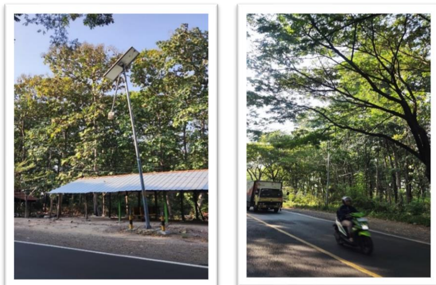
Gambar II. 11 Kondisi Eksisting Lampu Penerangan Jalan
