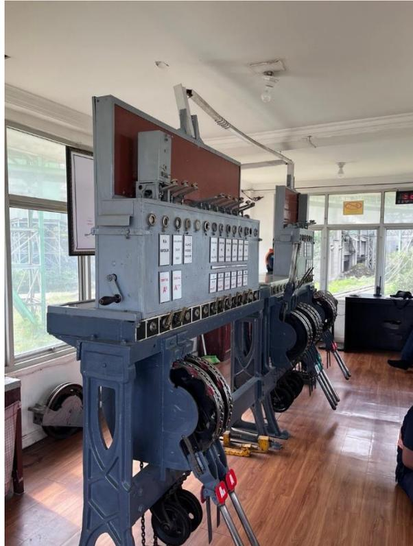
**Gambar II. 10** Pesawat Blok Elektro Mekanik
