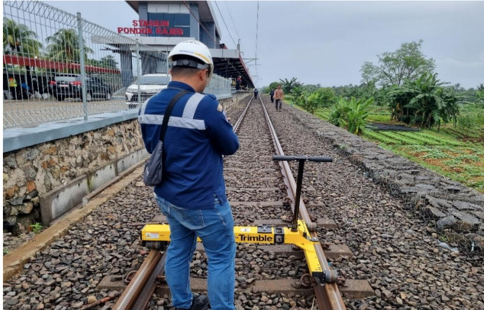
Gambar II. 7 Pengujian Pertama Jalan Rel Km 41+500 Lintas Citayam-Nambo
