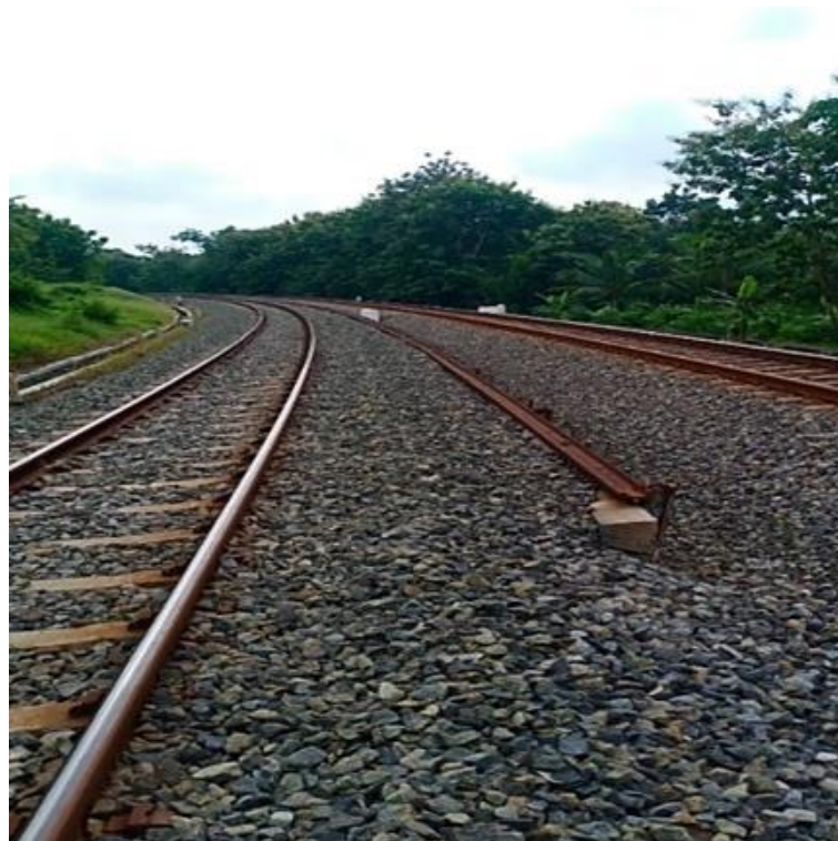
Gambar II.7 Kondisi Lengkung Nomor 28 I Km 520+387 – Km 521+232 Jalur Hilir Lintas Wates – Sentolo Sumber: Dokumentasi Pribadi
