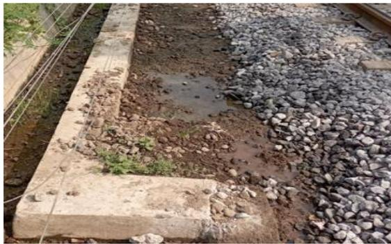
**Gambar V. 3** Mud pumping Yang Terjadi Sepanjang Tahun Pada Area di Samping Jalur Rel
