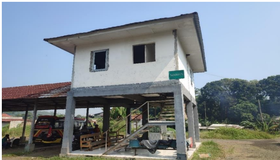
Gambar II. 18 Kantor Penyelenggara Terminal Jubleg Sumber: Dokumentasi Pribadi
