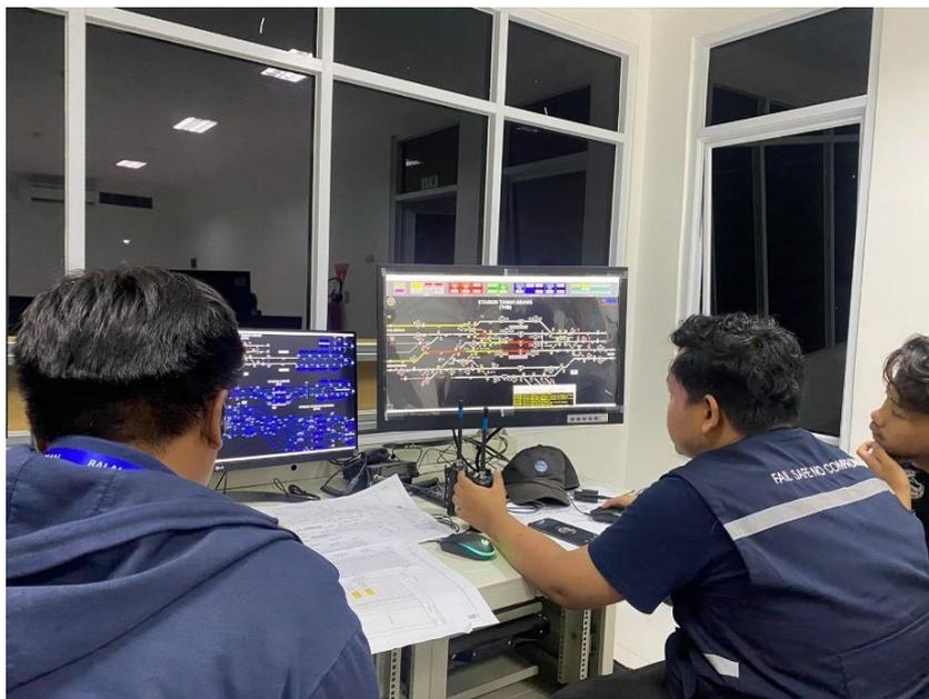
**Gambar II. 15** Pengujian Indikasi *Visual Display Unit (VDU)*
