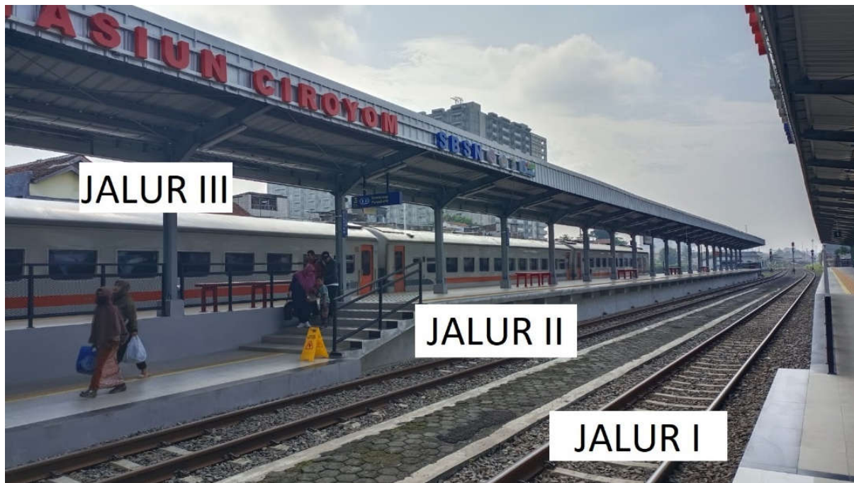
Gambar 4. Kondisi Emplasemen Stasiun Ciroyom
