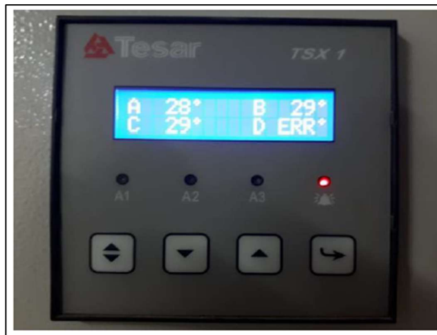
Gambar II.14 Perangkat Proteksi Temperature Rectifier Trafo
