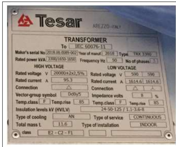
Gambar II. 11 Spesifikasi Rectifier Transformer
