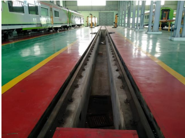
Gambar II. 12 Jalur Perawatan dengan Kolong pada Jalur 2
