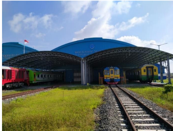
Gambar II. 10 Gedung Workshop Lokasi Perawatan Sarana
