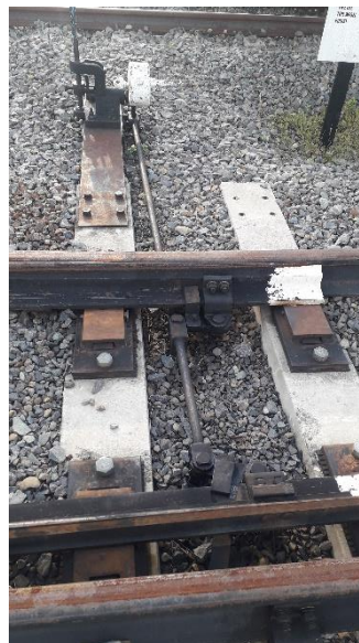
Gambar V. 1 Wesel Pada Jalur di Balai Perawatan Perkeretaapian
