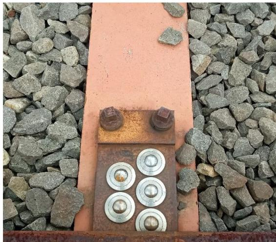
**Gambar V. 8** *Ball Bearing* pada depo MRT Jakarta mengalami korosi
